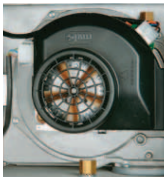
Постоянно контролирано горене (модулиращ вентилатор)
